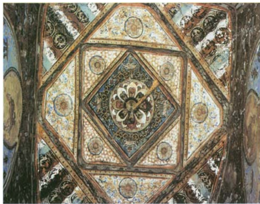
图 17 阿契寺“大塔”内塔塔顶（庞卡摄）
