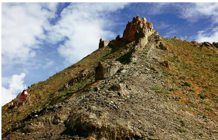
图五 廊道L1全景(南→北)
