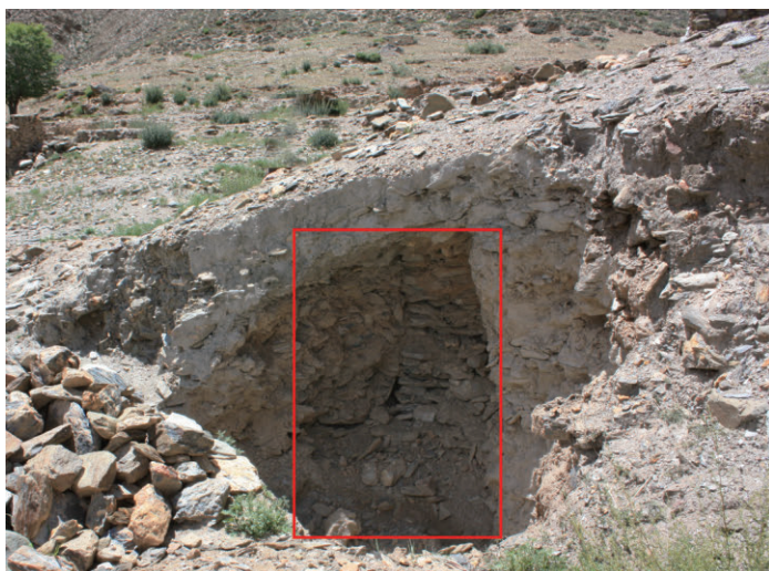
图五 欧姆村 M5 裸露墙体
